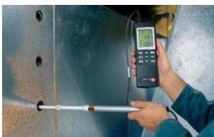
空调通风系统调试
