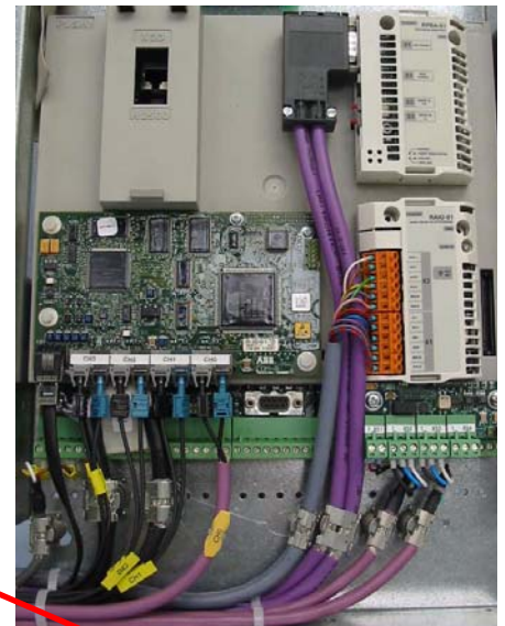
用金属夹连接电缆屏蔽到安装板的金属表面
