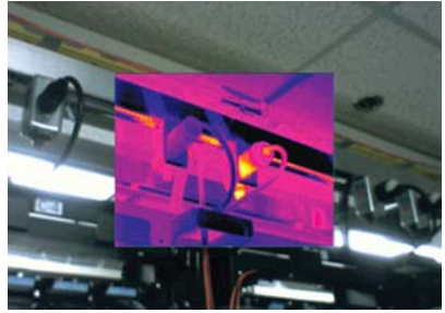
图 5-81. 计算机服务器机柜上的右侧电线插 头显示的热图案指示存在高电阻连接或内部 接线问题。
