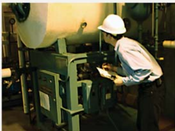
图 10-1.维护技术人员通过执行视觉和听觉检查,对操作设备的外观和声音进行例行检测。
