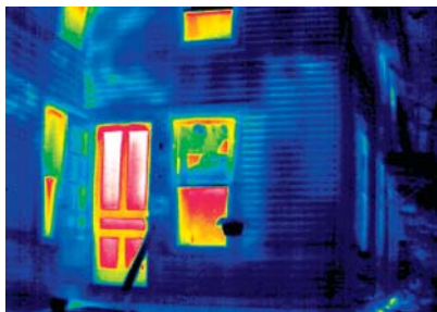
图 5-51. 热成像技术可用于记录各种问题,例如保温材料缺失或受损。
