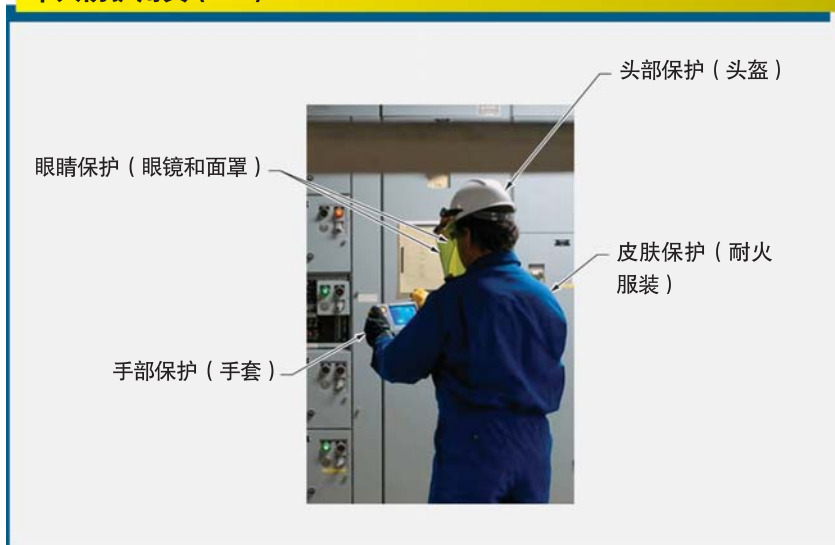
图 6-1. PPE 通常包括对眼睛、头部、皮肤和手部的保护,旨在消除电弧闪光的高温和其它危险造成潜在伤害。
