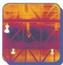
屋顶/水渍损害
