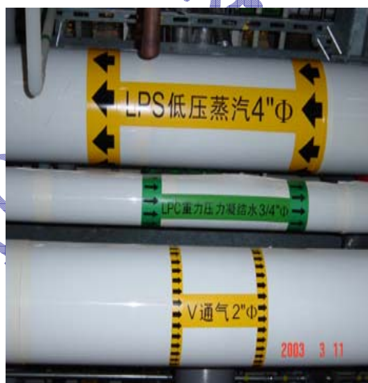
无任何标识的管道不知里面是液体、气体，冷、热或流向。
