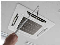
空调出风口测试
