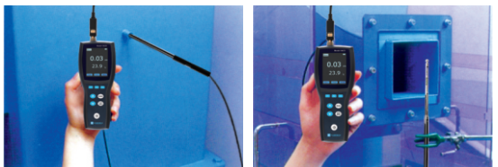
管道内风速、风量测试
