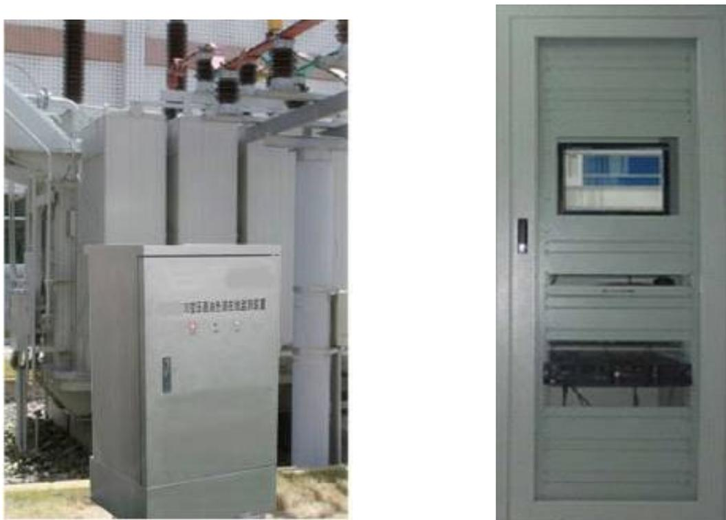
图 2.2 LYGCXT5000 变压器油色谱在线监测系统实物照片
