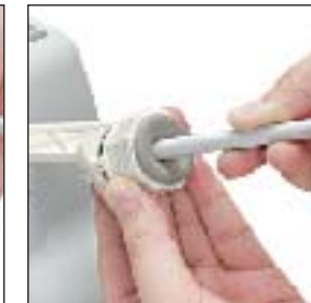
2.拔出防水接头进行接线
