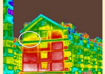
建筑外墙保温层缺失，白圈处需要重新安装保温层
