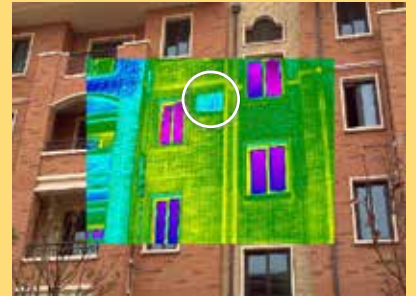
外墙维修后未填实，该处容易渗水
