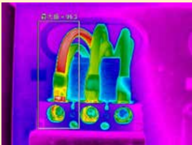
电气线缆过载三相不平衡
