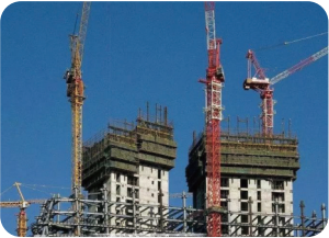
施工竣工测量
