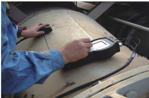
管道腐蚀检测
