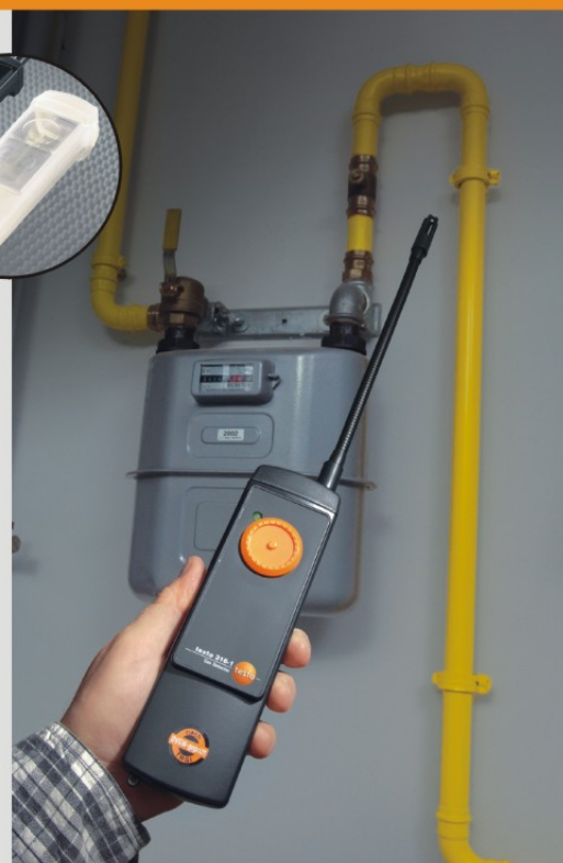
检测家用气管的泄露情况
