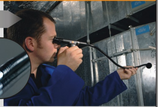
用中等柔性的S型弯管检测管道
