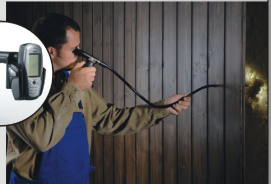
使用坚固的脱碳管来检测绝缘层
