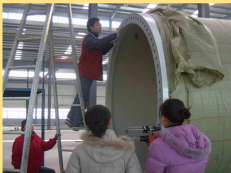
塔架法兰出厂检测
