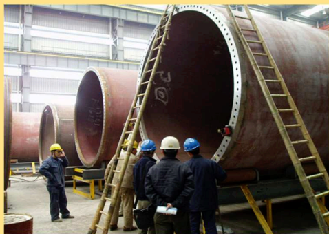
塔架法兰预装检测
