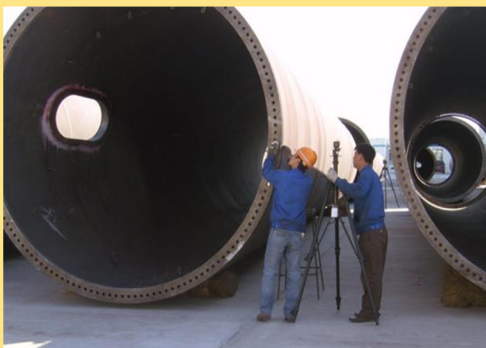
塔架法兰平行度检测
