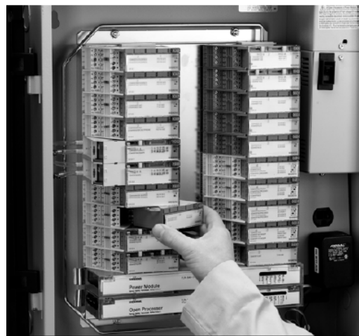
图5：搭扣式模块便于安装和替换
