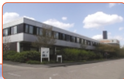
位于德国的集团公司总部
