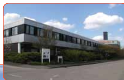
位于德国的集团公司总部
