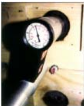
用 Lok-Test 检测早期拆模时间
